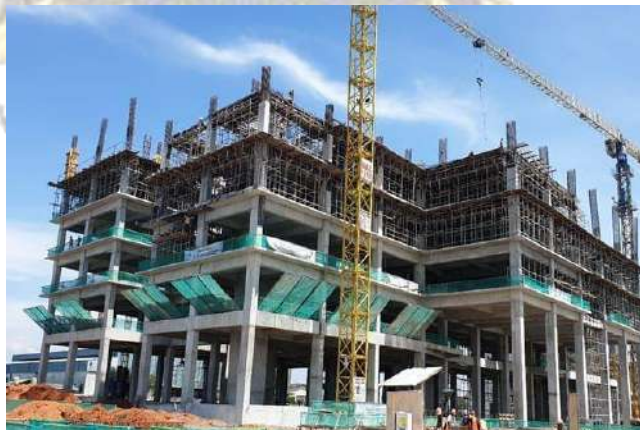
Gambar 2. 2 Konstruksi Bangunan Gedung
