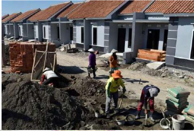
Gambar 2. 1 Konstruksi Bangunan Perumahan
