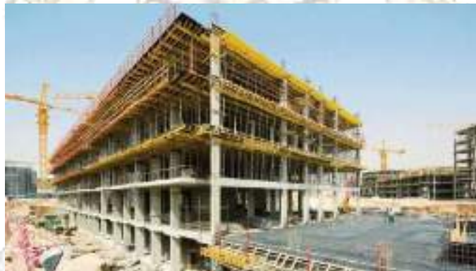
Gambar 2. 2 Proyek Konstruksi Bangunan Gedung
