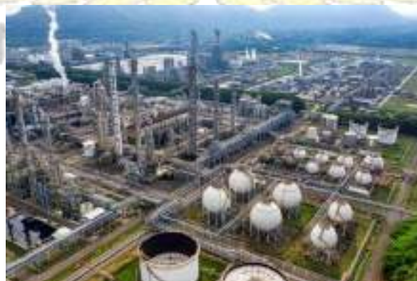
Gambar 2. 4 Proyek Konstruksi Bangunan Industri Sumber : Amarta Consulting, 2022
