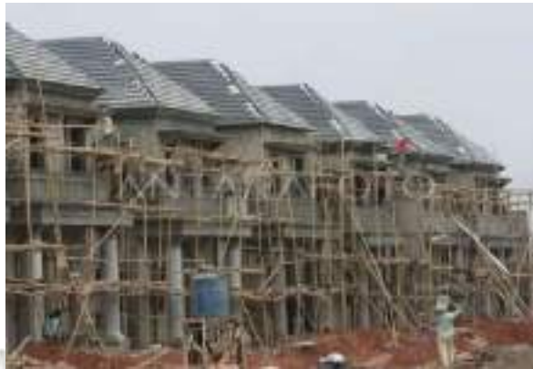
Gambar 2. 3 Proyek Konstruksi Perumahan Sumber : Alwi, 2013
