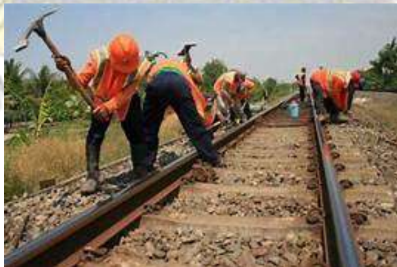
Gambar 2. 1 Proyek Konstruksi Rel Kereta Api Sumber : Wulandari, 2017
