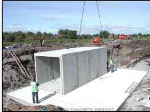
Gambar 2. 14 Proses pemasangan beton precast di lapangan
