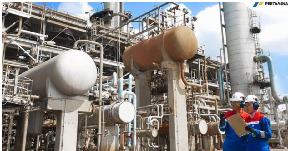
Gambar 2.4 Proyek Konstruksi Industri ( Industrial Construction ) Sumber: Kabar Tuban , 2020
