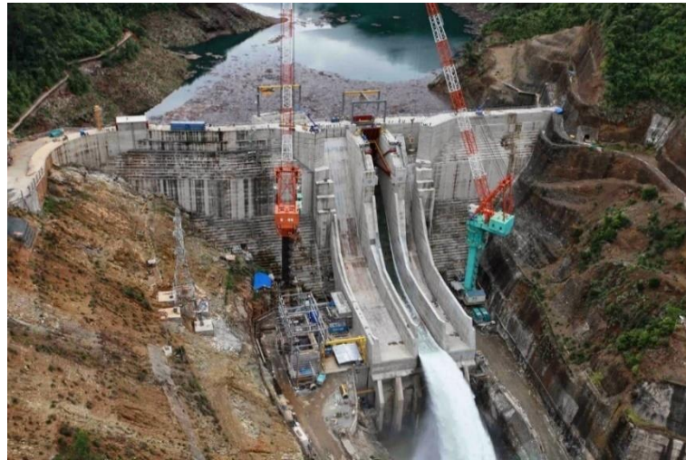
Gambar 2.1 Proyek Konstruksi Teknik Sipil ( Heavy Construction )
