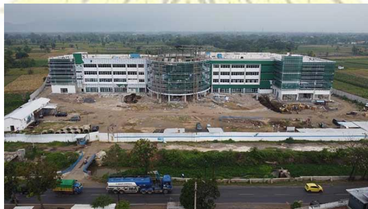
Gambar 2.2 Proyek Konstruksi Bangunan Gedung
