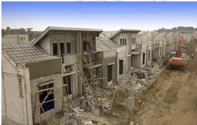
Gambar 2.3 Proyek Konstruksi Perumahan ( Residential Construction )
