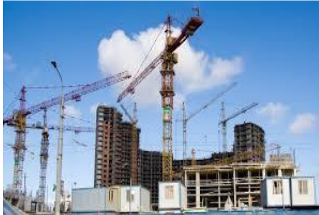
Gambar 2.3 Proyek konstruksi Bangunan Industri (Sumber: Google, 2024)
