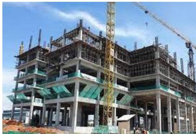
Gambar 2.2 Proyek konstruksi Bangunan Gedung (Sumber: Google, 2024)
