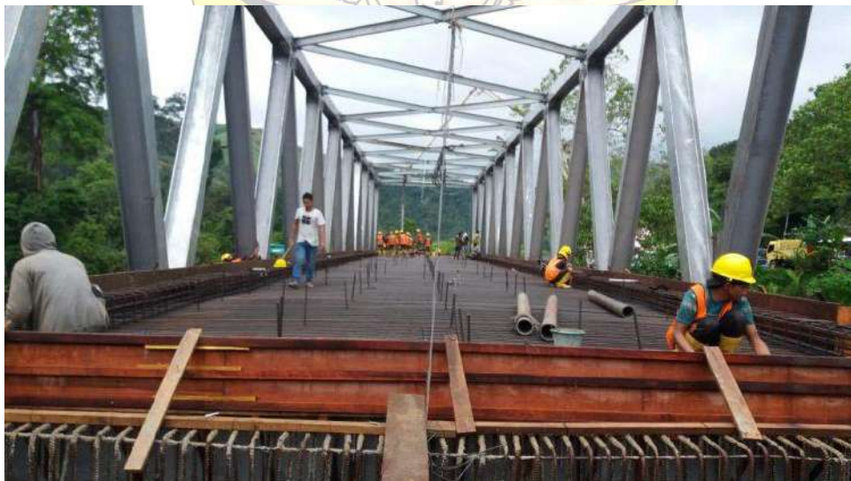
Gambar 2.6 Proyek Konstruksi Jembatan
