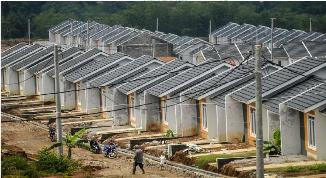
Gambar 2.2 Proyek Konstruksi Perumahan
