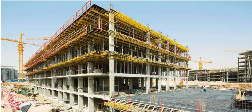
Gambar 2.5 Proyek Konstruksi Gedung
