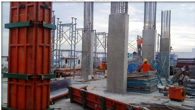
Gambar 2.7 Kolom beton bertulang
