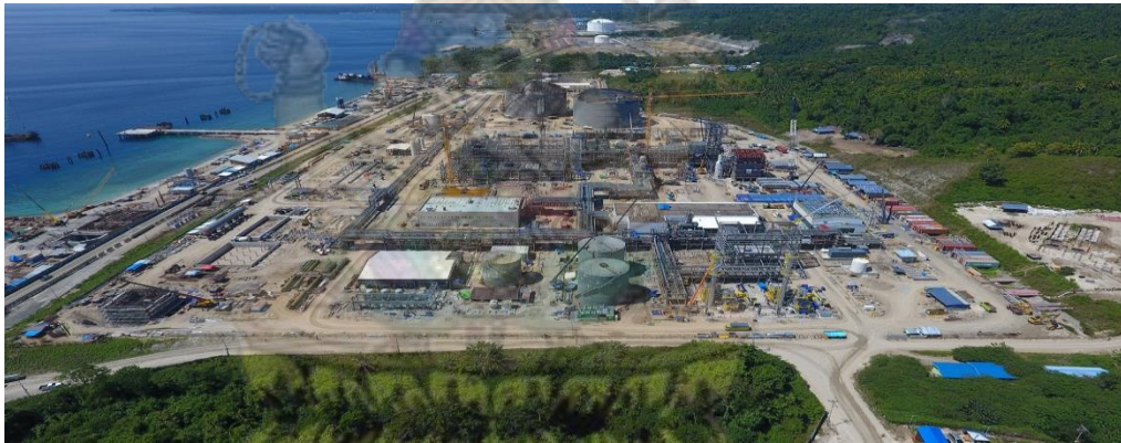
Gambar 2. 13 Proyek Konstruksi Bangunan Industri
