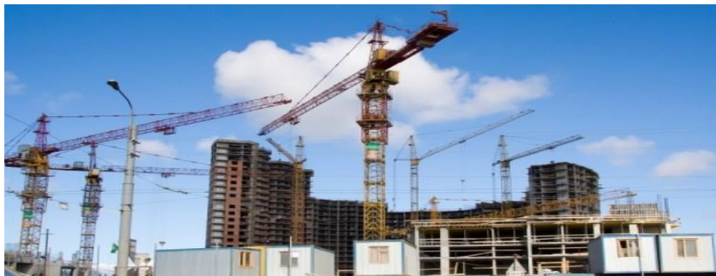
Gambar 2. 12 Proyek konstruksi bangunan gedung
