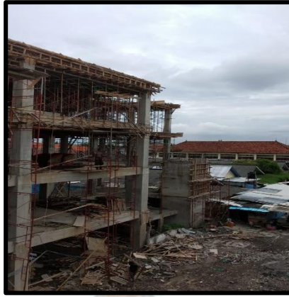
Gambar 2.1 Proyek Konstruksi Bangunan Gedung (Sumber : Dokumentasi Penulis, 2023)
