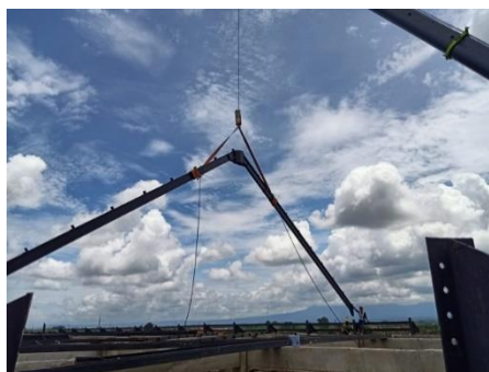
Gambar 2.1 Proyek Konstruksi Baja Sumber : Dokumentasi Penulis, 2021
