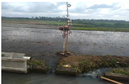
Foto 8. Bangunan bagi yang membagi air ke setiap lahan sawah anggota subak (Foto :Sukanteri)
