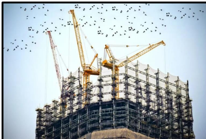
Gambar 2.2 Proyek Konstruksi Bangunan Industri ( Industrial Construction ) (Sumber: unsplash.com, 2022)
