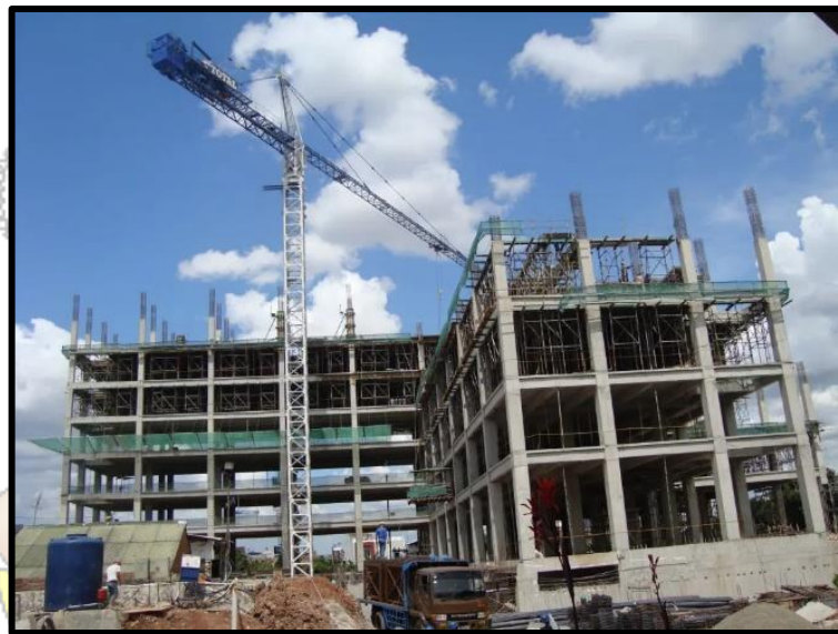
Gambar 2.3 Proyek Konstruksi Bangunan Gedung (Sumber: blogspot.com , 2022)
