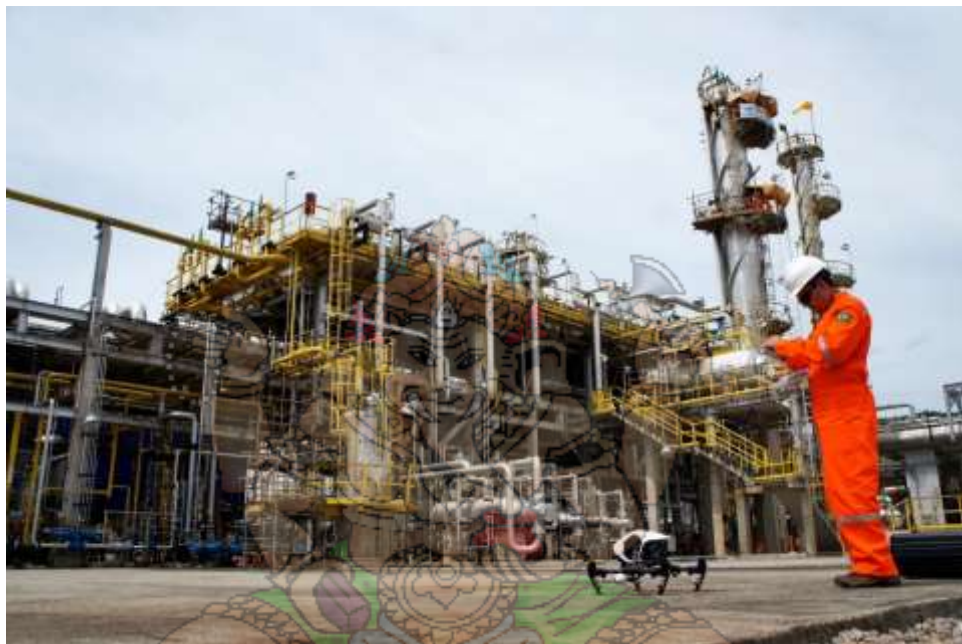
Gambar 2. 4 Contoh proyek konstruksi bangunan industri
