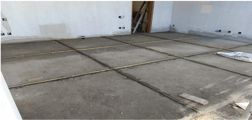
Gambar 17 Pelat Beton (Sumber : CV. Bali Gedeg, 2022)
