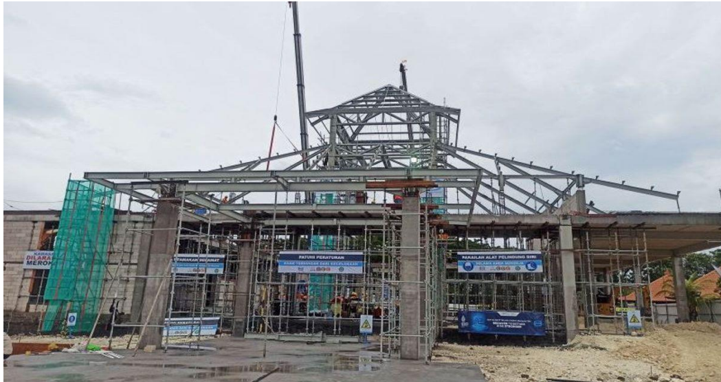
Gambar 2 Kegiatan Konstruksi Terminal VVIP Bandara Ngurah Rai (Sumber : PT. VOI Media Informasi, 2022)
