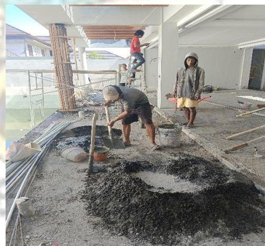
Gambar 20 Pencampuran Beton di Lokasi (Sumber : CV. Bali Gedeg, 2022)
