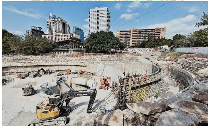
Gambar 2. 1 Proyek Konstruksi Teknik Sipil ( Heavy Construction )
