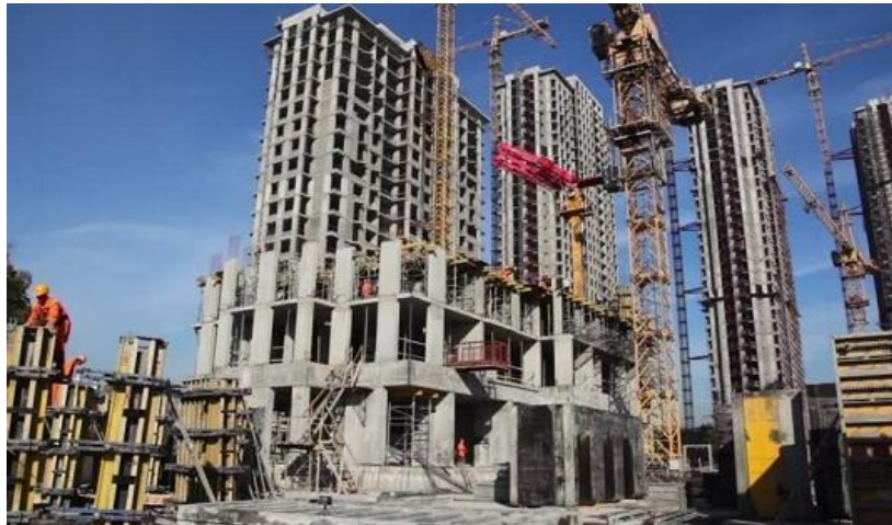
Gambar 2. 2 Proyek Konstruksi Bangunan Gedung
