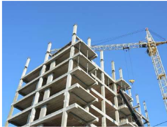
Gambar 2. 2 Proyek Konstruksi Bangunan Gedung (Sumber: Salsabila, 2023)
