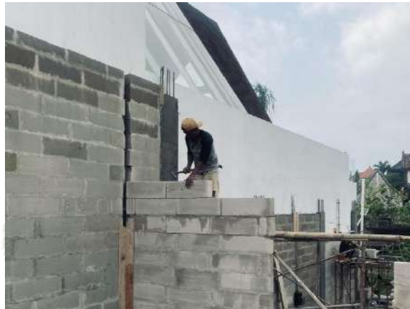
Gambar 2. 9 Contoh Pekerjaan Pemasangan Dinding Bata Ringan
