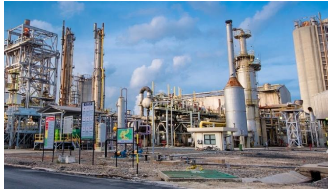
Gambar 2. 4 Proyek Industri (Sumber: www.medcom.id )
