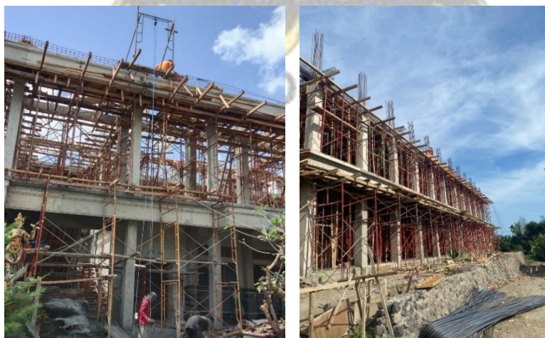
Gambar 2. 2 Proyek Pembangunan Sekolah
