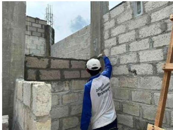
Gambar 2. 10 Contoh Pekerjaan Pemasangan Dinding Batako (Sumber: Info Publik, 2023)
