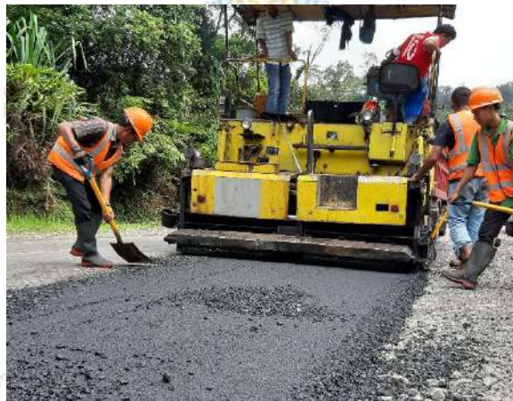
Gambar 2. 4 Proyek Konstruksi Jalan Raya (Sumber: Suhendar, 2023)
