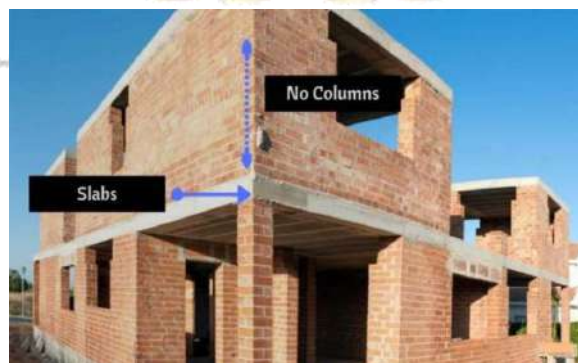
Gambar 2. 5 Dinding Struktural (Sumber: Dinaka Struktur, 2025)
