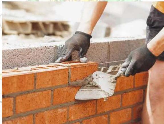
Gambar 2. 8 Contoh Pekerjaan Pasangan Dinding Bata Merah (Sumber: Brilian, 2024)
