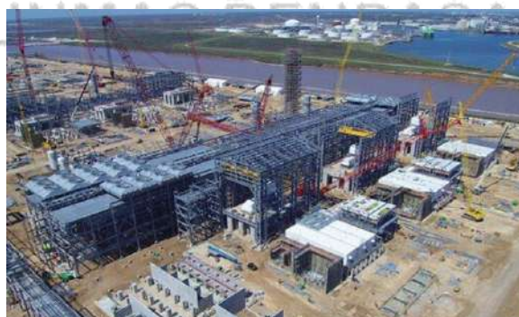
Gambar 2. 3 Proyek Konstruksi Bangunan Industri (Sumber: Novotest, 2025)
