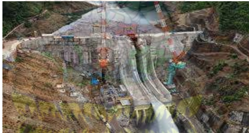
Gambar 2.4 Proyek waduk (sumber : Kementrian PUPR, 2021)
