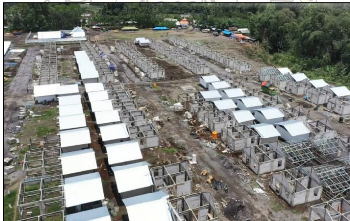
Gambar 2.2 Proyek pembangunan permukiman
