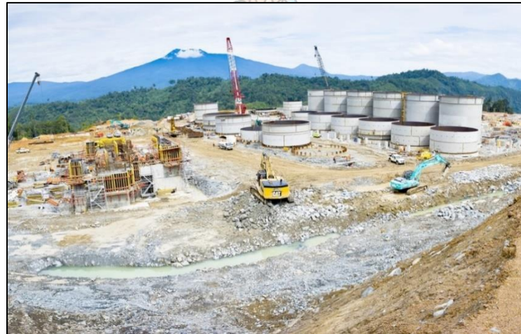
Gambar 2.3 Proyek pembangunan industri pada proyek pertambangan Sumber gambar: https://www.beritasatu.com/
