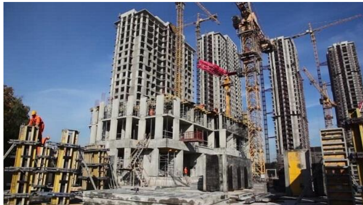
Gambar 2.3 Proyek Konstruksi bangunan gedung
