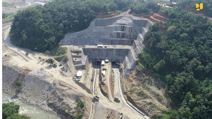
Gambar 2.6 Proyek bendungan (Sumber: Kementerian PUPR, 2020)
