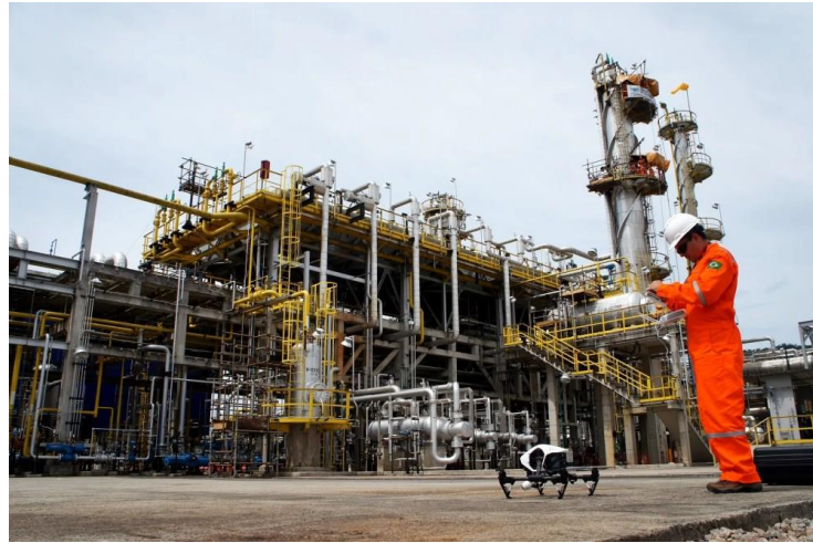
Gambar 2. 4 Proyek Konstruksi Bangunan Industri (Industrial Construction) (Dekoruma, 2018)
