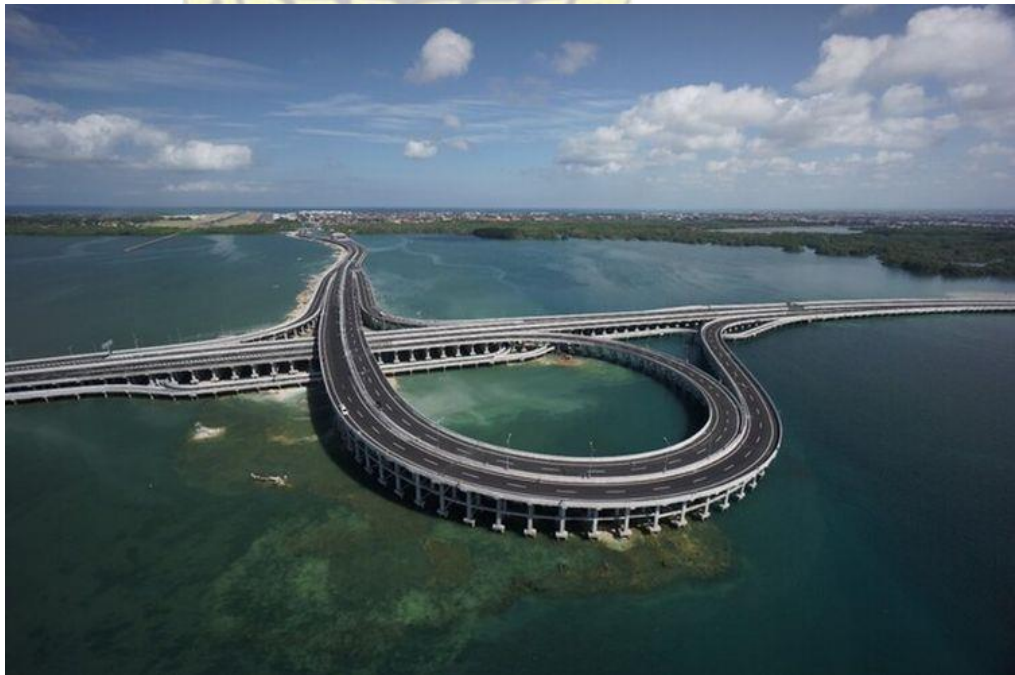
Gambar 2. 4 Bangunan Sipil Sumber : Google (2023)
