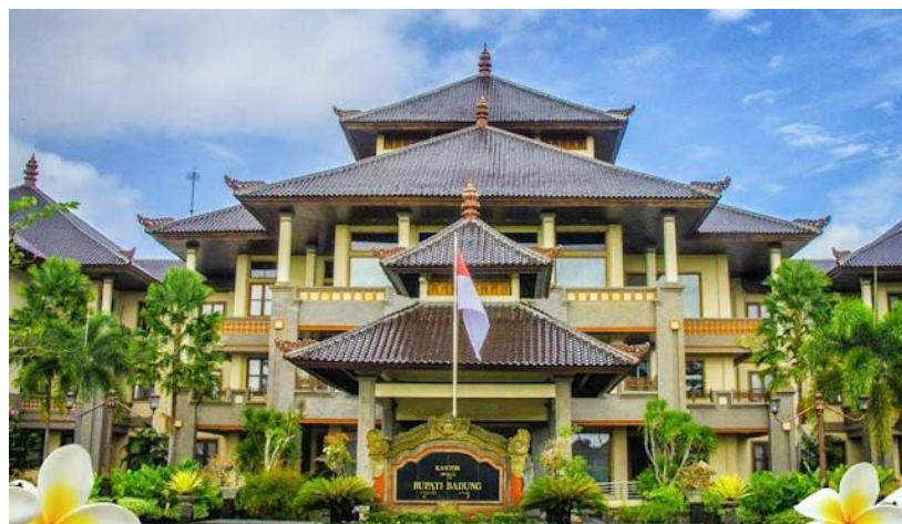
Gambar 2. 3 Bangunan Gedung Sumber : Google (2023)
