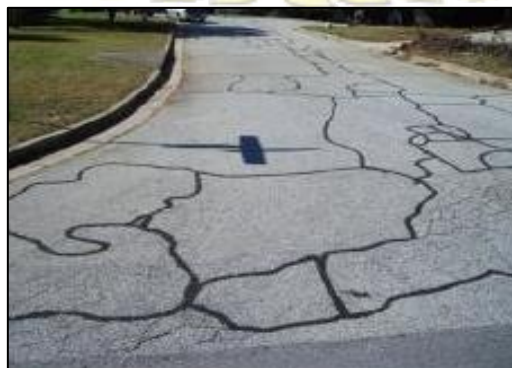
Gambar 2.5 Retak blok
