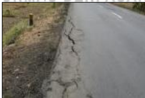
Gambar 2.7 Retak tepi
