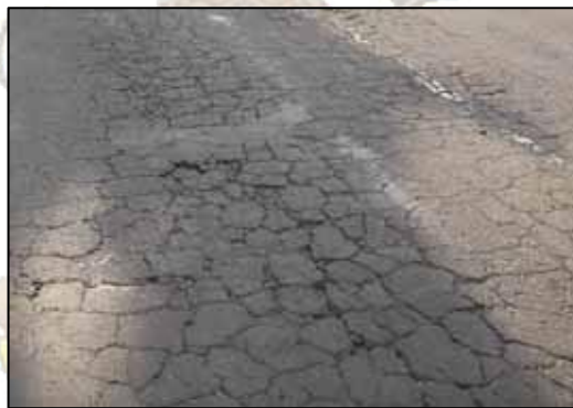
Gambar 2.1 Retak Kulit Buaya
