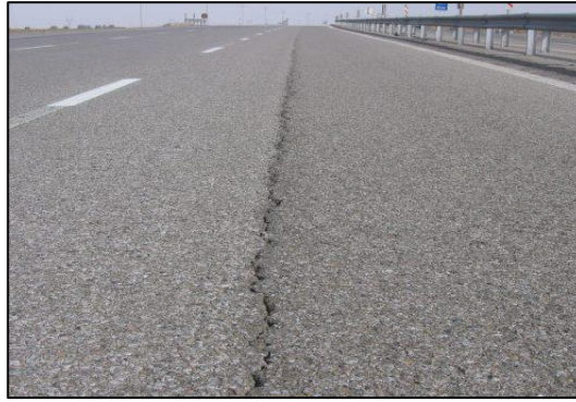
Gambar 2.8 Retak memanjang
