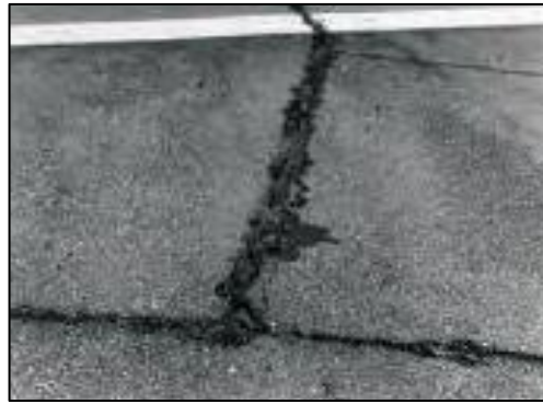
Gambar 2.15 Retak sambung
