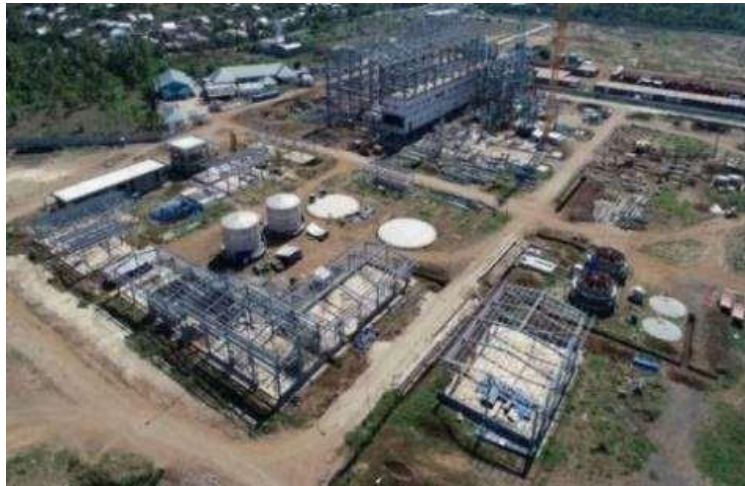
Gambar 2.2 Proyek Engineering Konstruksi
