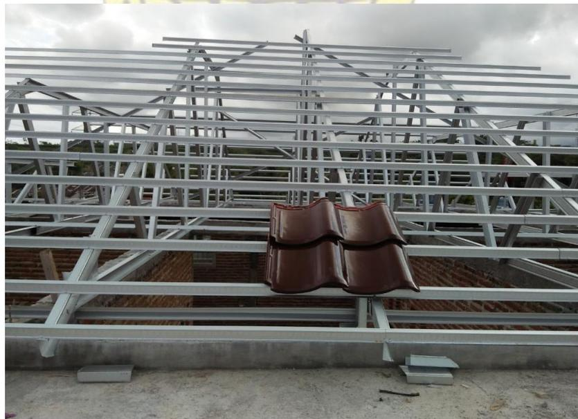
**Gambar 2.9 Rangka Atap Baja Ringan**
