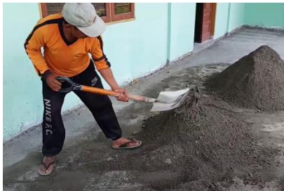
Gambar 2.6 Cara Pengadukan Manual (Sumber: Hidayat.R, 2020)
