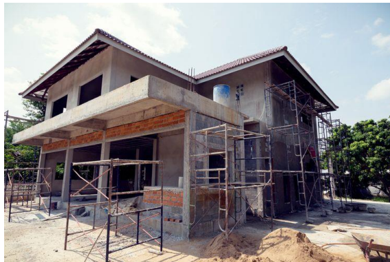
Gambar 2.1 Proyek konstruksi perumahan ( Residential Construction ) (Sumber: kompas, 2021)
