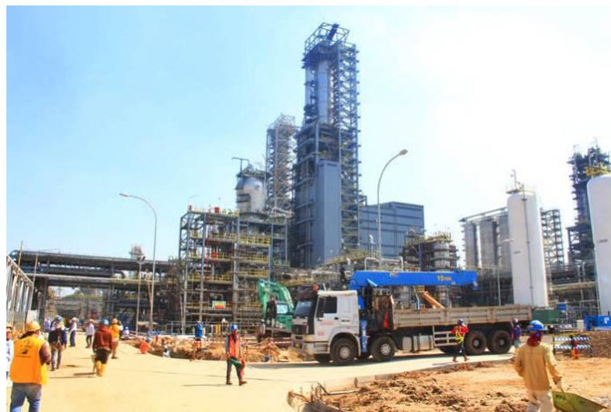
Gambar 2.3 Proyek konstruksi bangunan industri (Sumber: Fajar Taufik, 2020)
