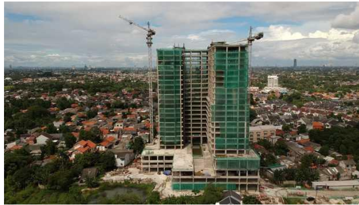
Gambar 2.2 Proyek konstruksi bangunan gedung (Sumber: Fajar Taufik, 2020)
