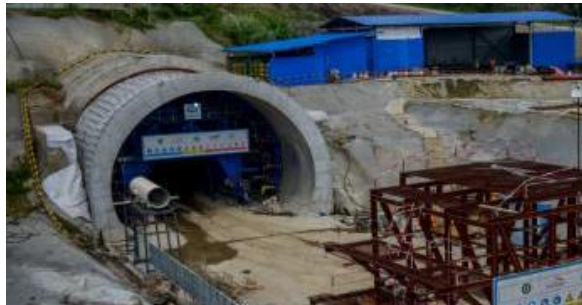
Gambar 2.4 Proyek konstruksi teknik sipil (Sumber: Kompas, 2021)
